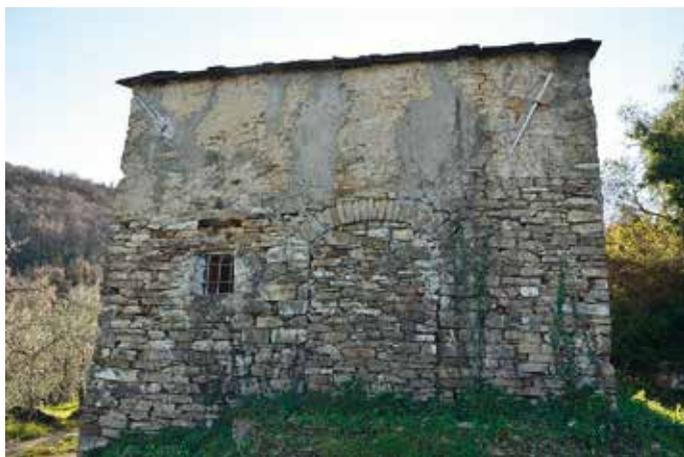
Fig. 4 - L'arco tamponato del muro nord del casone. (Foto G.P.M.)
