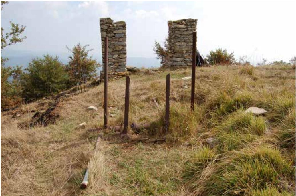
Fig. 6. Cian Faudò (Prelà). Argano per mettere in tensione (o rilasciare) la corda.
