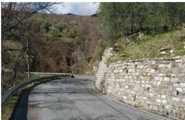
*Fig. 7. Aurigo. Muro di controripa presso il ponte de Rue Grande, eseguito con corsi di pietre regolarizzati con "stuccatura" di cemento rifinita a "filo" di cazzuola.*
