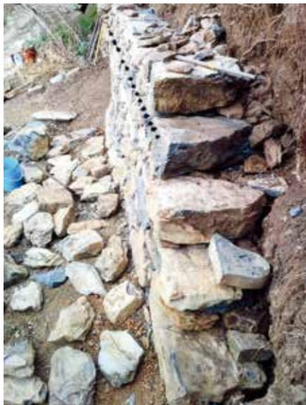
Fig. 11. Inizio della messa in opera del "cappello".
