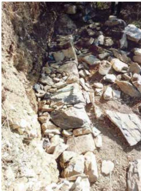
Fig. 7. Filare di base con pietrame inzeppato e di riempimento nella parte interna del muro.
