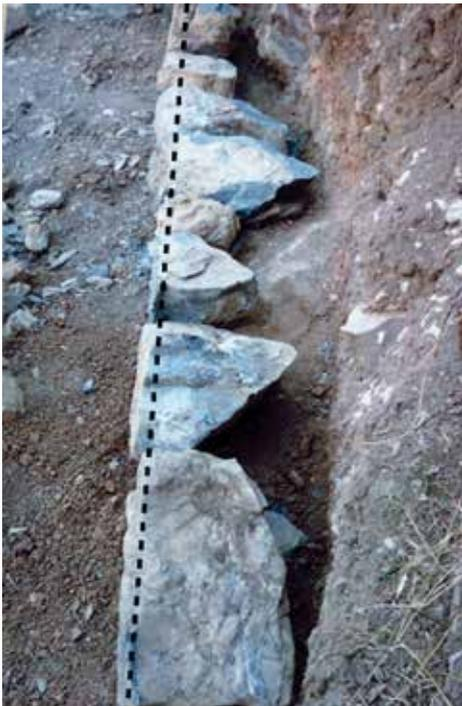
Fig. 4. La "linea ideale" del filare di base del muro non deve passare davanti ma sopra alle facce delle pietre.
