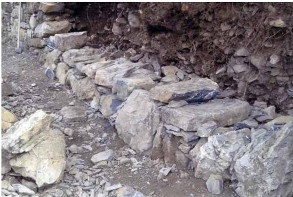
Fig. 8. Messa in opera dei "piastroni" del secondo filare del muro.
