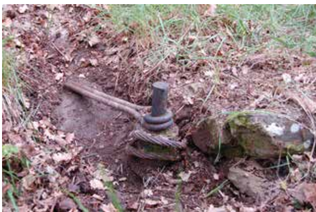
Fig. 10. Ville San Pietro, Pœzzu du Canevâ. Ancoraggio di partenza della corda Canevâ-Cappella di Santa Lucia (Borgata Costa).
